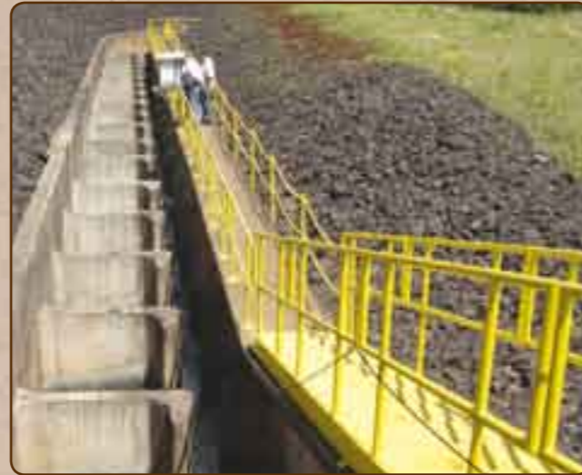
escada para transposição de peixes na UHE Igarapava ladder for fish transfer at UHE Igarapava
